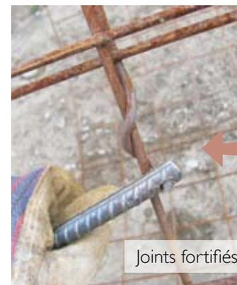
4. Fortifier les joints du cylindre en enroulant ensemble la broche excédentaire des carreaux coupés et la broche de calibre 9;
