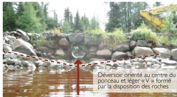
Déversoir orienté au centre du ponceau et léger «V» formé par la disposition des roches
