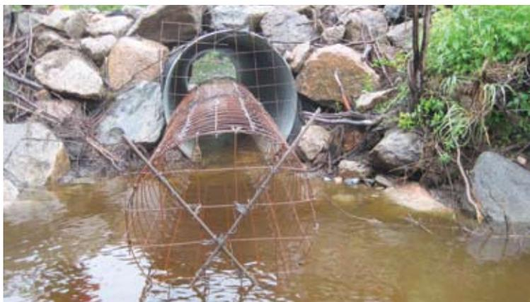
Avec de la broche, il est également possible d'attacher le cylindre au ponceau en perçant ce dernier.
